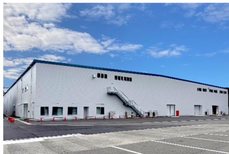
新設した生産設備の外観
