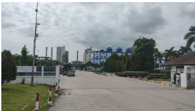
エアバッグ原糸生産工場建設地の IPI ラヨーン工場
