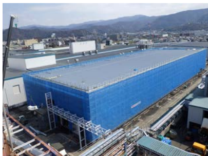
1 号機と 2 号機が設置される工場棟(建設中)
