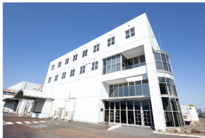
大津医薬工場の外観
