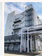
新設した培養・精製棟
