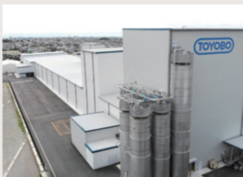
犬山工場に新設した製造設備
