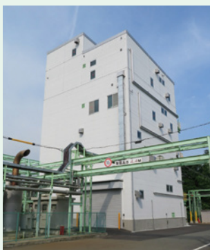
高砂工場に新設した「ハードレン®」の製造設備
