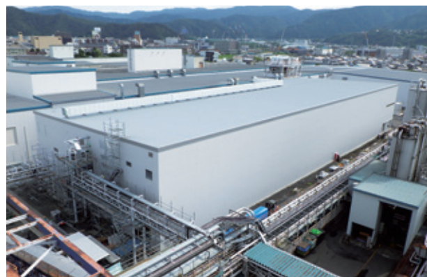
1号機と2号機が設置される工場棟(建設中)
