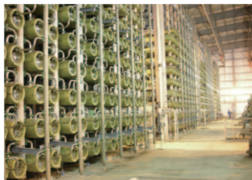
サウジアラビア ラービグ地区海水淡水化設備
