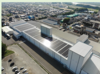
犬山工場の屋上に設置された1,608枚の太陽光パネル、発電出力は約500kW
